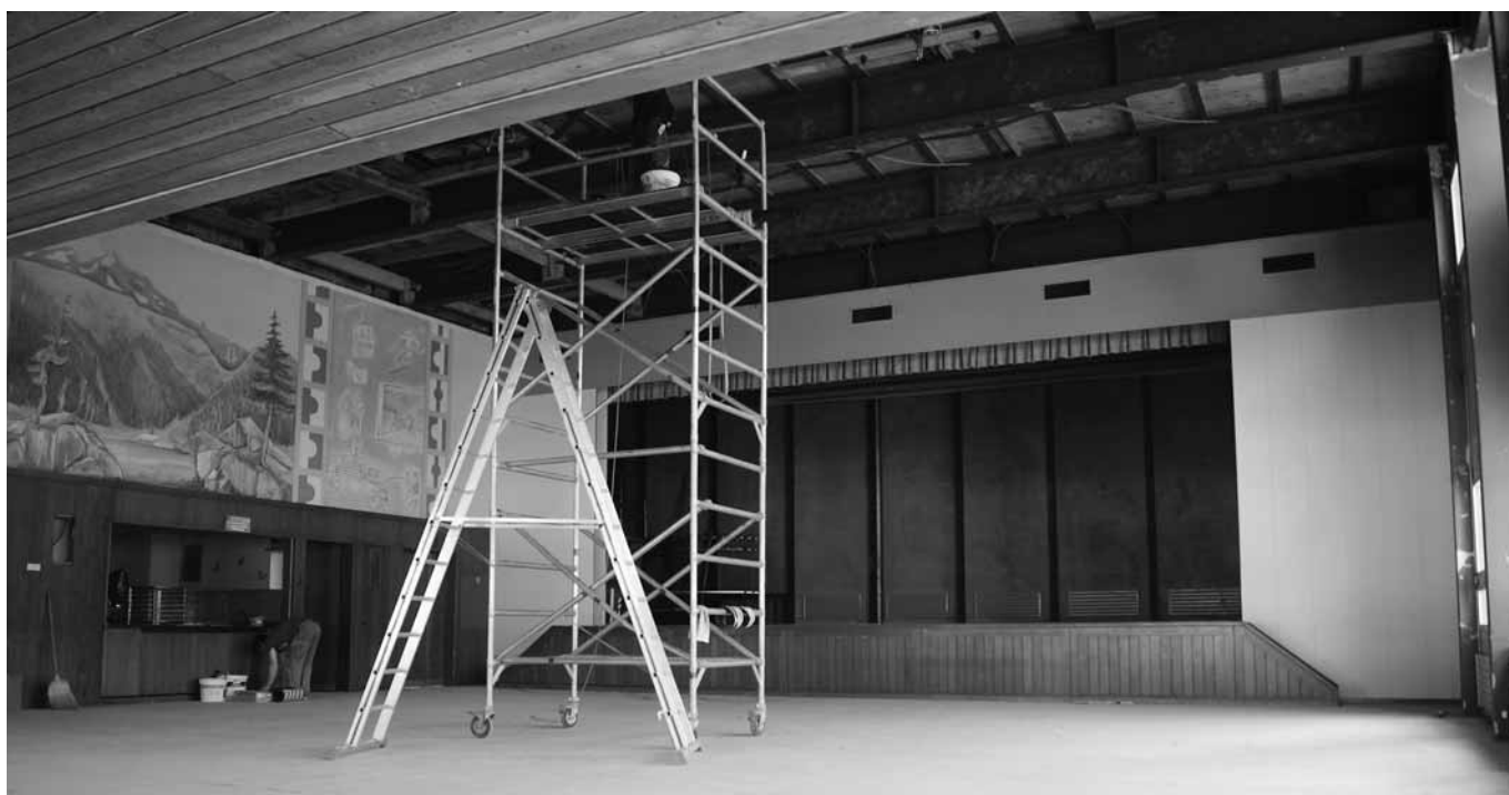
Die Sanierungsarbeiten haben im Saalinneren begonnen
